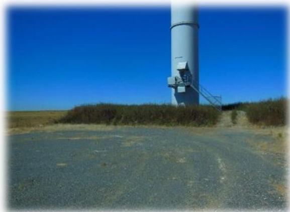
Figure 2 : Très bonne visibilité sur le chemin d'accès de l'éolienne CCN3 (T. Cherpitel - Ecosphère)
