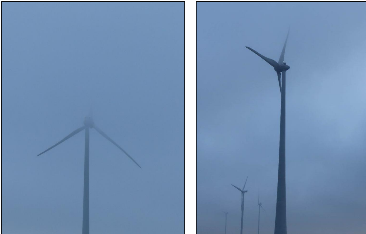
Figure 2 : Exemple de situation à risque : brouillard en hauteur masquant tout ou partie des pales.
