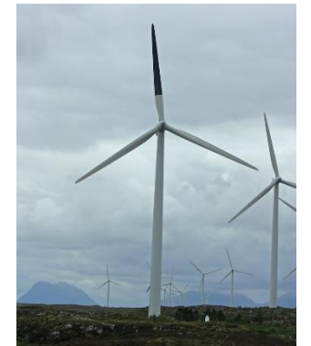
Figure 2 : éolienne avec une pale peinte en noire.
