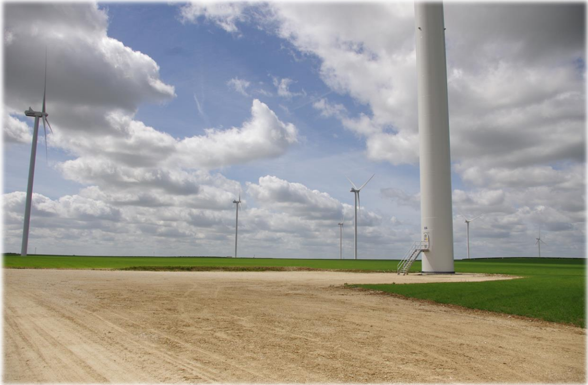
Figure 4 : Plateforme et semis de blé autour de l'éolienne E6
