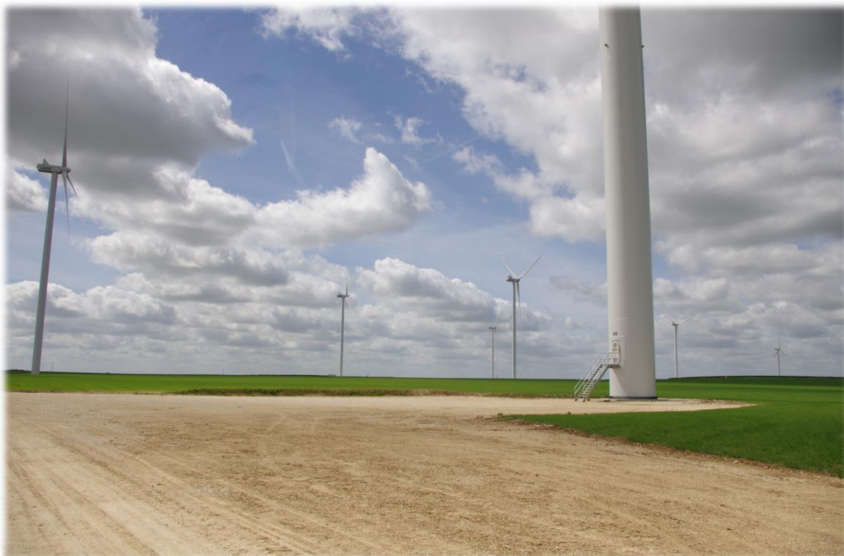
Figure 2 : Plateforme et semis de blé autour de l'éolienne E6
