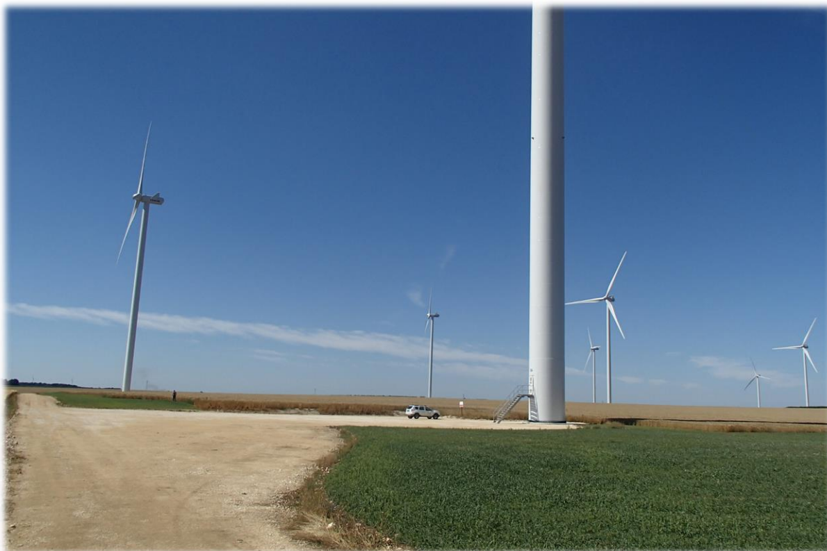
Figure 1 : Vue sur l'éolienne E6, et sur les éoliennes E2 à E7 en arrière-plan. Au fond, une éolienne du parc de Longchamp
