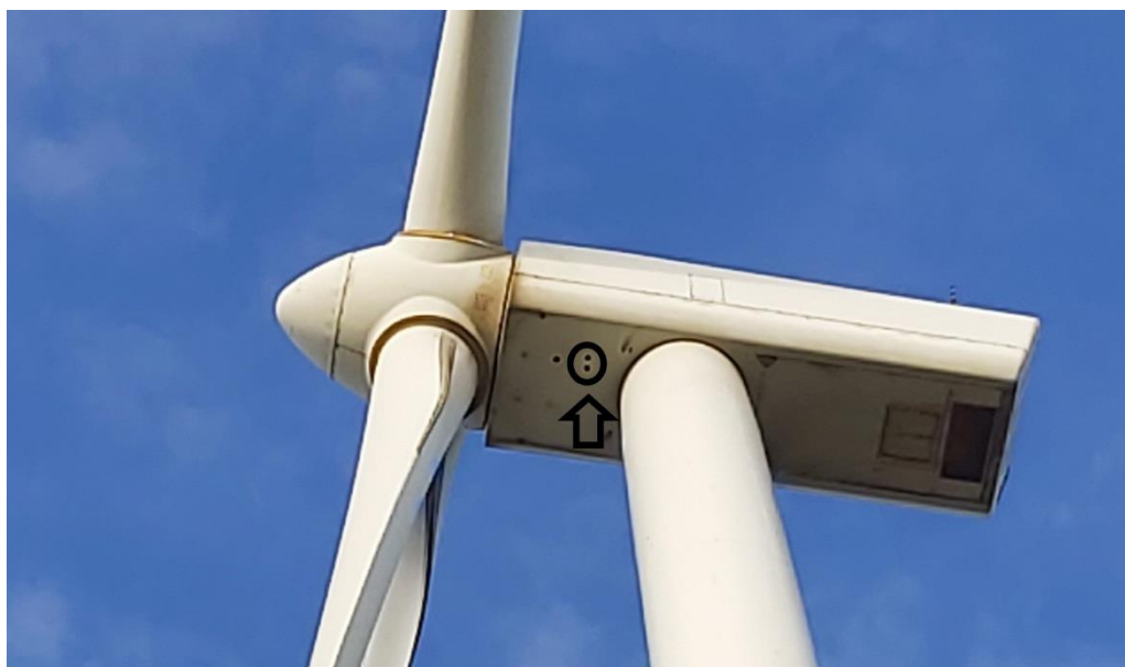
Figure 2 : exemple d'installation d'un BATmode en nacelle
