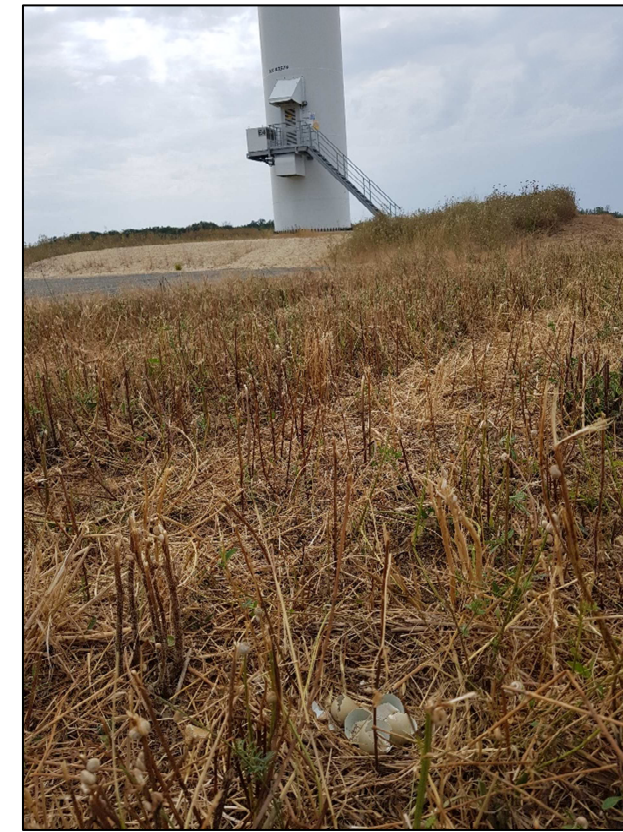
Figure 4 : Cliché de l'éolienne E4
