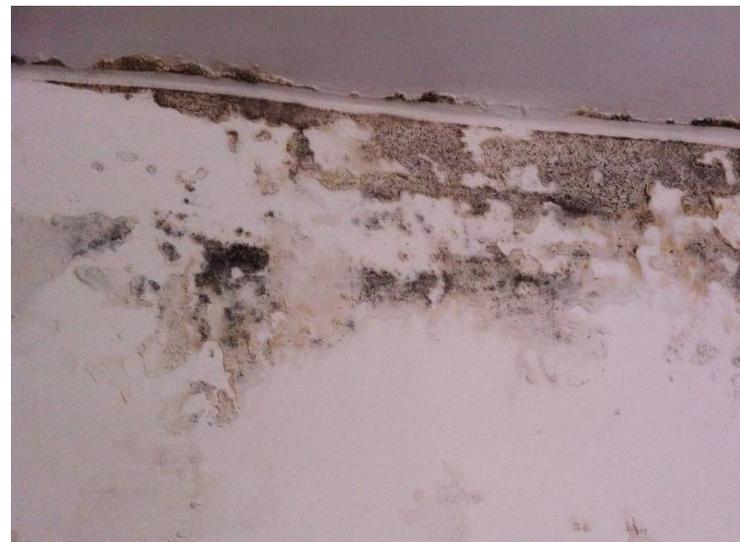
**Présence de ponts thermiques ou des défauts d'étanchéité générés par des discontinuités pouvant engendrer des condensations, des décollements ou des moisissures.**
