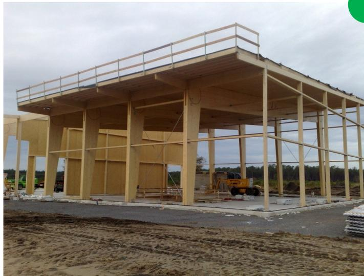
**Absence de protection des isolants et des produits biosourcés en phase chantier.
