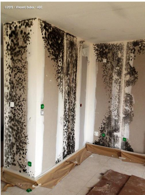
**Apparition de moisissures due à la difficulté de séchage des supports (renforcement de l'étanchéité à l'air et absence de ventilation).**
