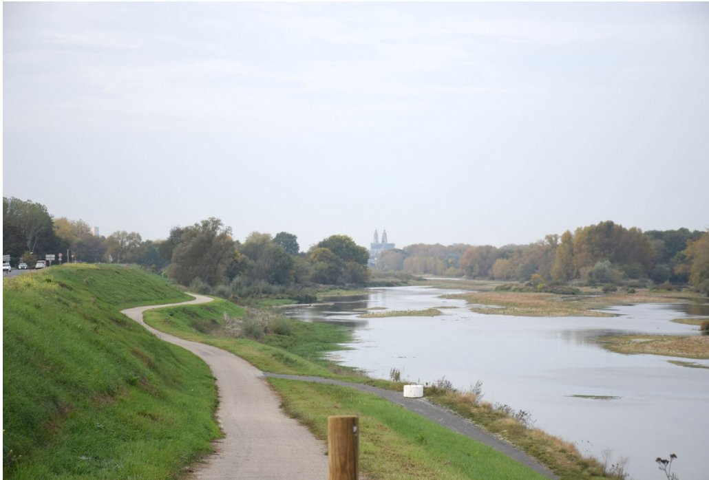
St-Pierre-des-Corps, levée (RD 751)
