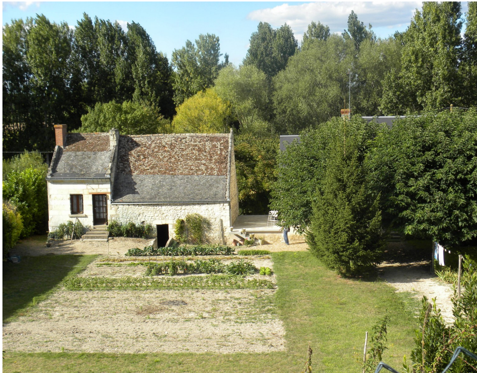
Huismes, ardoises, tuiles et tuffeau
