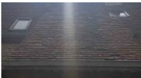
Vue d'ensemble – versant Nord
