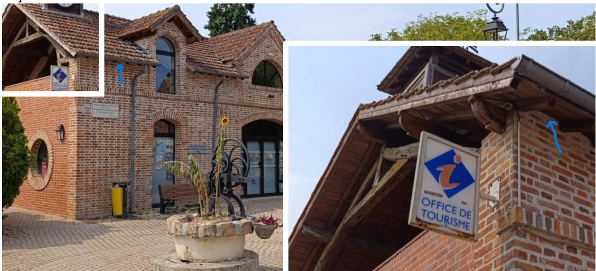
Façade favorable du bâtiment 2
