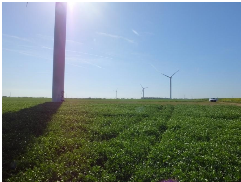
Photo 1 : Vue d'ensemble des éoliennes du parc de « Bois Bigot » depuis l'éolienne 1 (de gauche à droite : éolienne 1, 3, 4 et 2)
