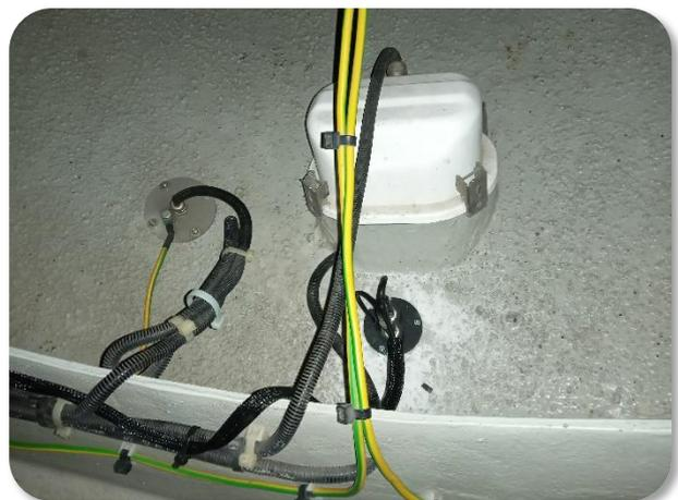
**Fixation et position du micro sous le spot d'éclairage**
