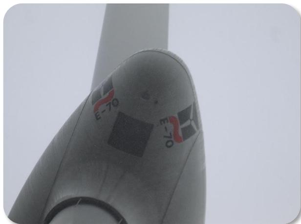
**Position finale du microphone ultrasonique (à l'extérieur de la nacelle) et du coffret (dans la nacelle)**
