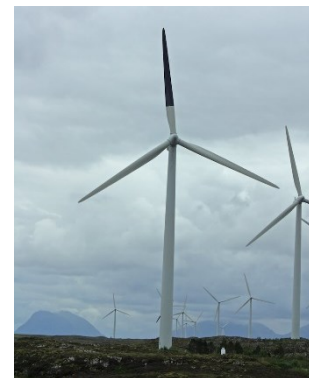
Figure 25 : Eolienne avec une pale peinte en noire.
