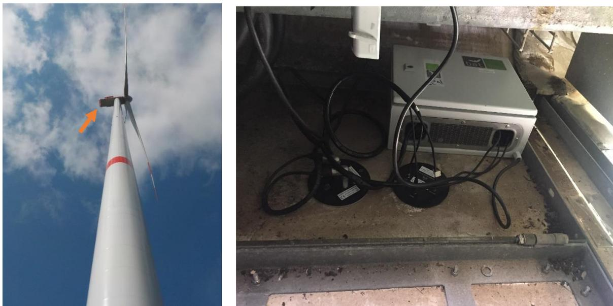
Figure 1 : À gauche, position du microphone au niveau d'une éolienne ; à droite, installation de l'enregistreur dans une nacelle d'éolienne.
