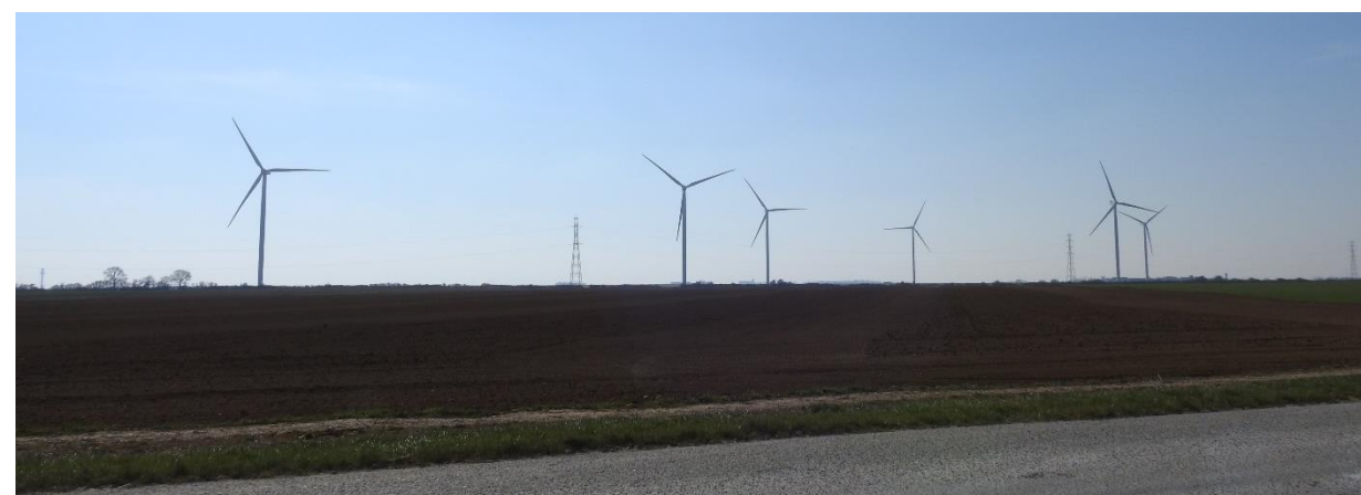
Figure 2 : Photo d'ensemble de la ferme éolienne de Genonville depuis la route D37.
