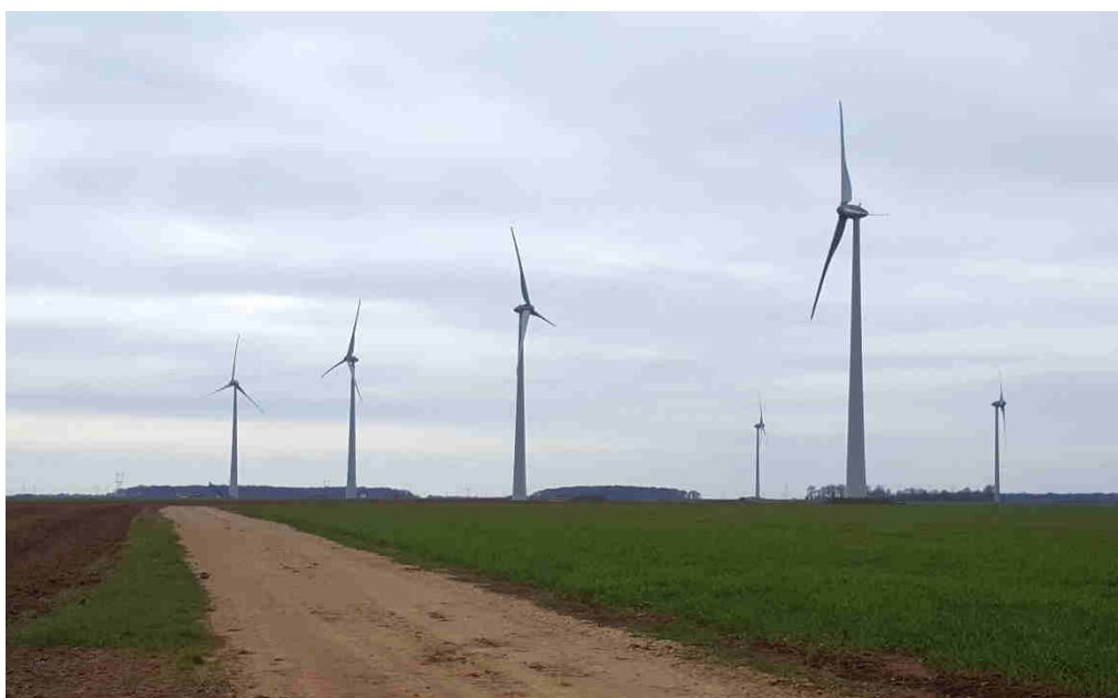
Parc éolien du Long Villiers vu depuis le nord-est
