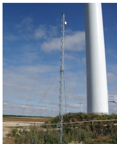
Photo 2 : mât au pied de l'éolienne E11
