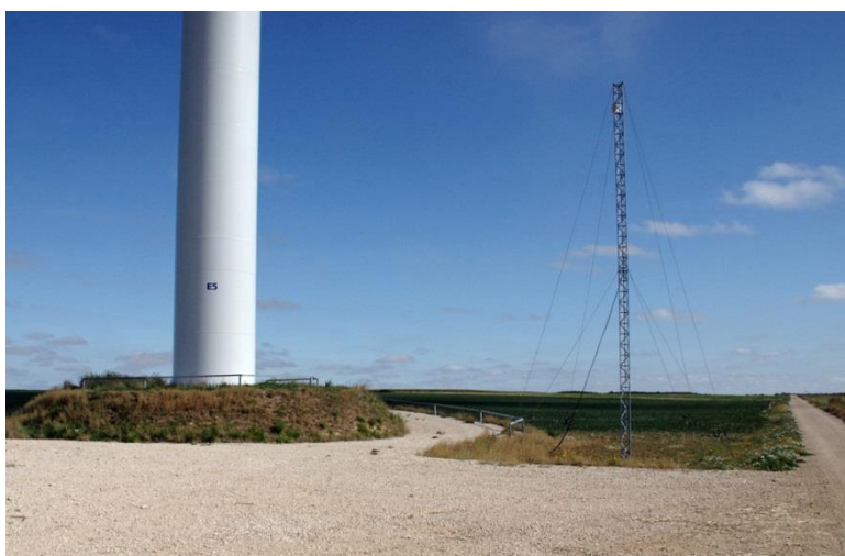
Photo 1 : mât au pied de l'éolienne E5
