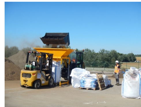
Mise en BB
