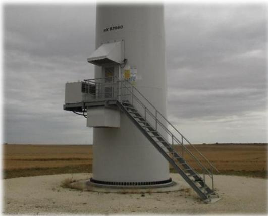
Photo 5 : Vue de la plateforme d'accès à l'éolienne AUB 7
