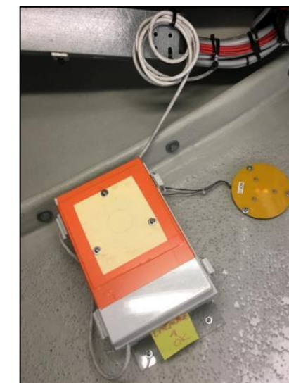
Figure 3 : Cliché de l'installation du Batcorder en nacelle avec micro à travers la paroi de la nacelle
