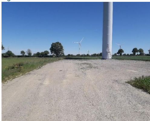
Figure 9 : Éolienne 9 le 15 mai 2019
