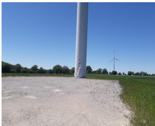
Figure 5 : Éolienne 5 le 15 mai 2019
