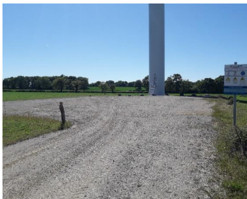
Figure 7 : Éolienne 7 le 15 mai 2019
