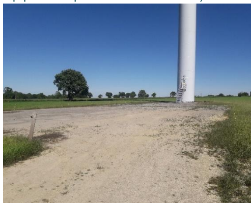
Figure 8 : Éolienne 8 le 15 mai 2019
