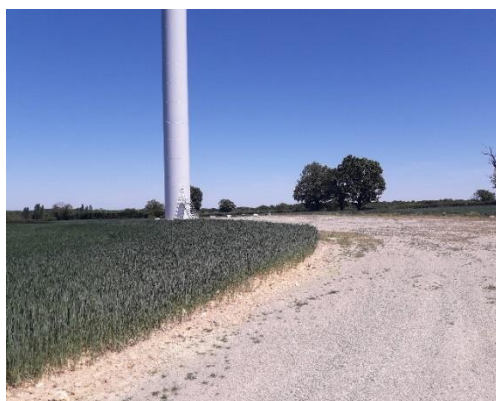
Figure 1 : Éolienne 1 le 15 mai 2019
