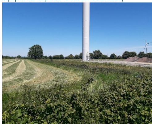
Figure 4 : Éolienne 4 le 15 mai 2019
