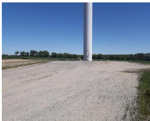
Figure 3 : Éolienne 3 le 15 mai 2019
