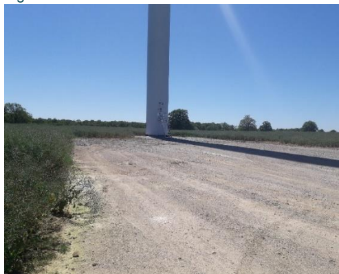
Figure 10 : Éolienne 10 le 15 mai 2019
