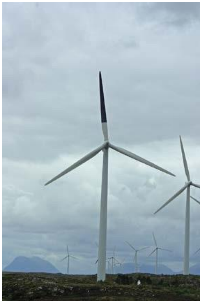
Illustration 9. Éolienne du parc de Smøla (Norvège) avec pale peinte (MAY R. et al, 2020)
