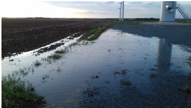
Photo 9 Eaux stagnantes et ornières (E2)
