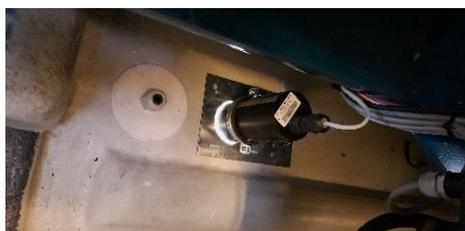
Figure 4 : Positionnement du microphone SMART au sein de l'éolienne
