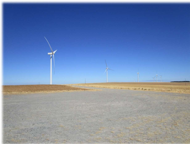
Figure 1 : Vue de six éoliennes du parc de « La Vallée » depuis l'éolienne 18 (éoliennes 17 à 12) - E.Brunet, Ecosphère
