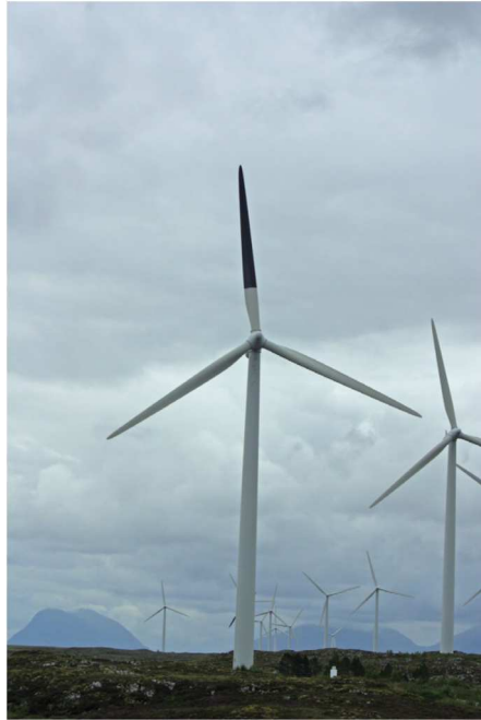
Éolienne du parc de Smøla (Norvège) avec pale peinte (MAY R. et al, 2020)
