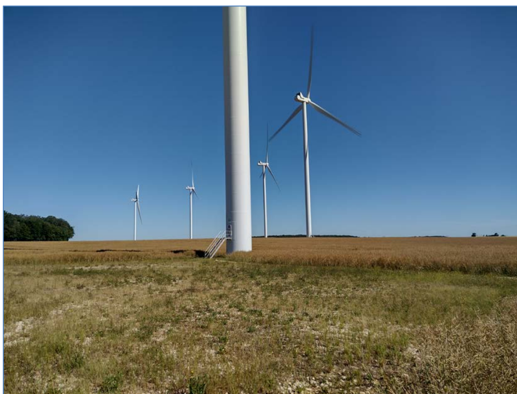
Couvert sous E5 au 13 juin 2022 + aire gravillonnée enherbée
