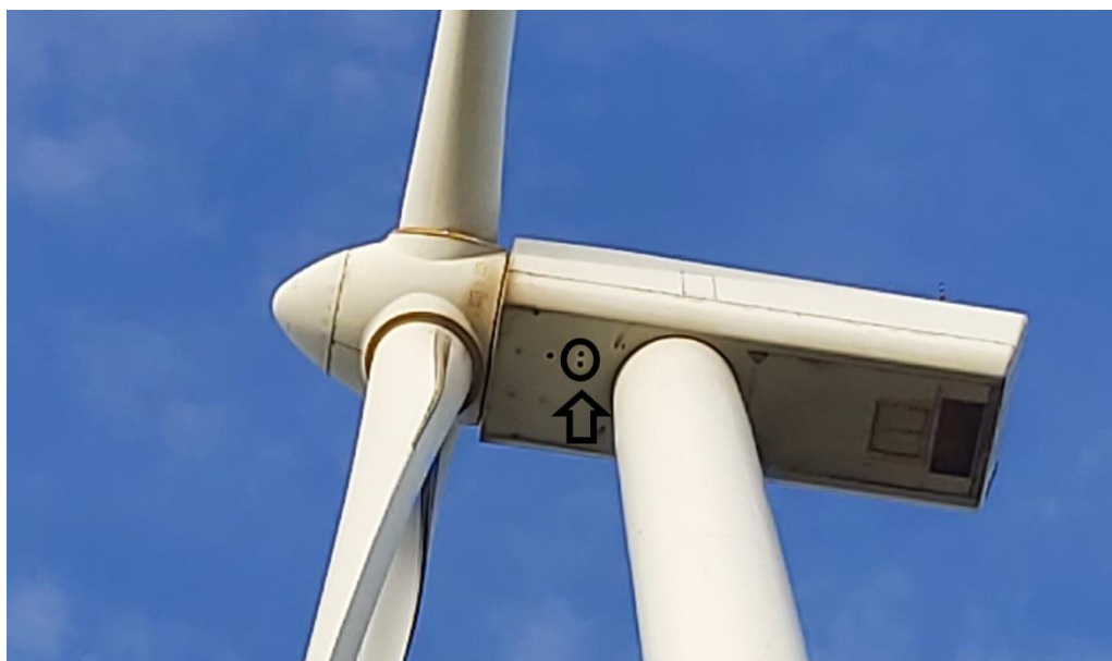
figure 1 : exemple d'installation d'un BATmode en nacelle
