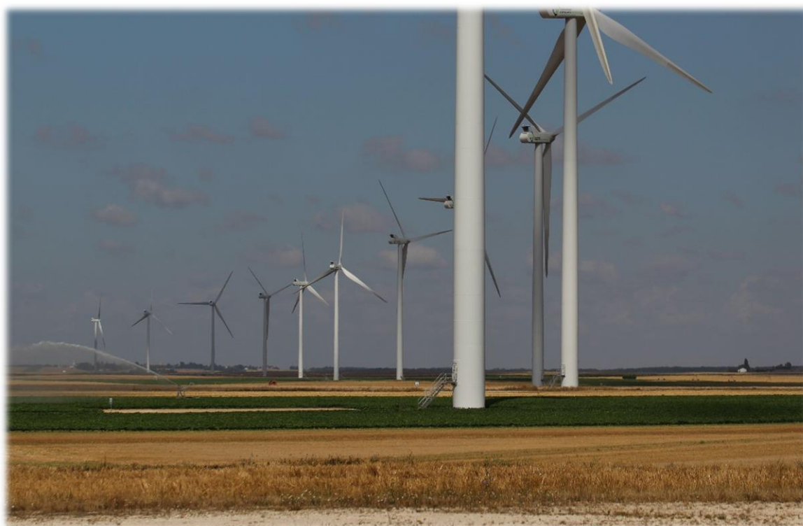
Photo 1 : Parc depuis l'éolienne E1 (E. Brunet, Écosphère)
