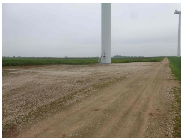
Figure 2 : Éolienne 2 le 15 mai 2018
