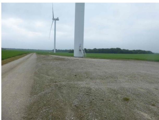
Figure 7 : Éolienne 7 le 15 mai 2018
