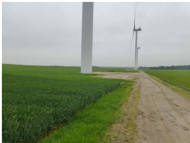
Figure 6 : Éolienne 6 le 15 mai 2018
