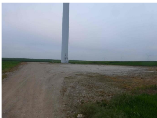
Figure 1 : Éolienne 1 le 15 mai 2018
