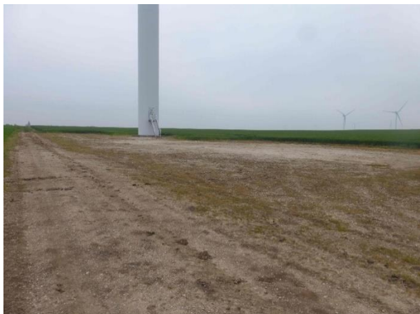
Figure 5 : Éolienne 5 le 15 mai 2018
