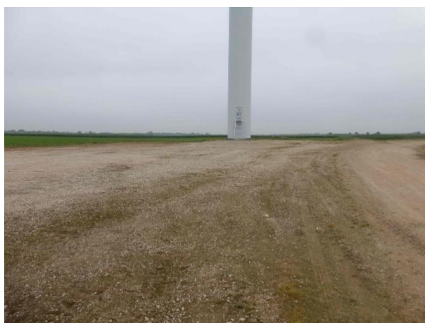
Figure 4 : Éolienne 4 le 15 mai 2018
