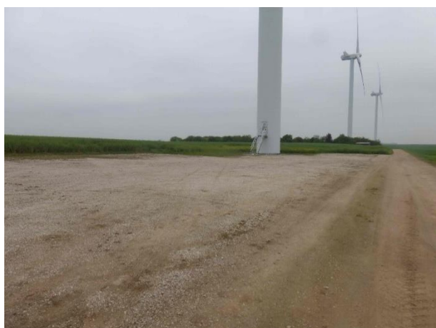
Figure 3 : Éolienne 3 le 15 mai 2018
