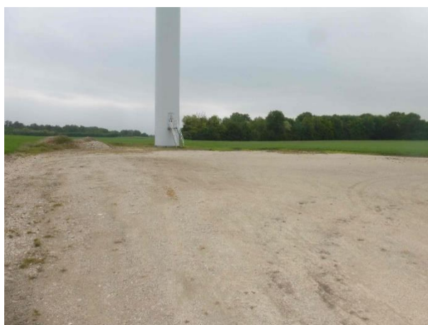
Figure 8 : Éolienne 8 le 15 mai 2018
