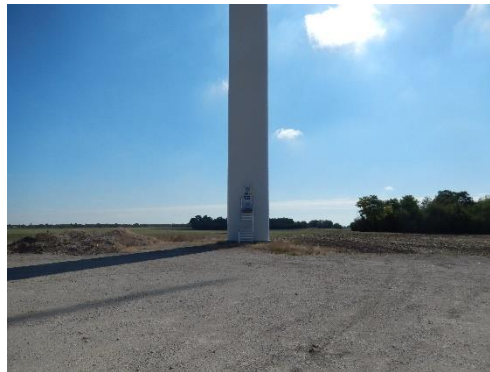
Figure 8 : Éolienne 8 le 10 septembre 2020
