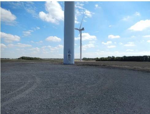
Figure 7 : Éolienne 7 le 10 septembre 2020
