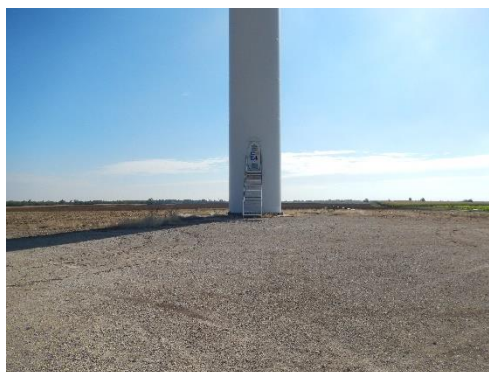
Figure 4 : Éolienne 4 le 10 septembre 2020
