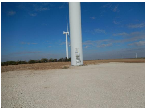
Figure 3 : Éolienne 3 le 10 septembre 2020
