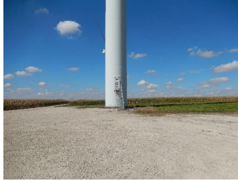
Figure 6 : Éolienne 6 le 10 septembre 2020
