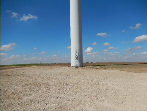
Figure 5 : Éolienne 5 le 10 septembre 2020
