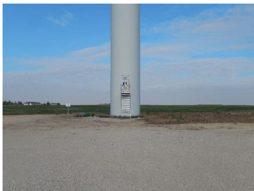
Figure 1 : Éolienne 1 le 10 septembre 2020
