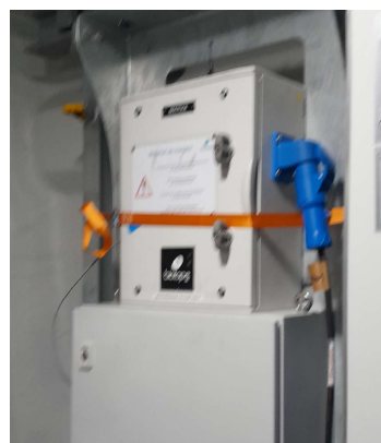
Photo enregistreur dans l'éolienne
