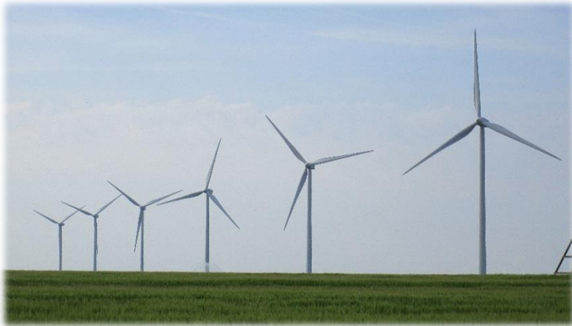
Photo 1 : Vue d'ensemble du parc de Patay
