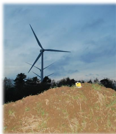
Photo 12 : AnabatSD1 installé au pied d'une éolienne
