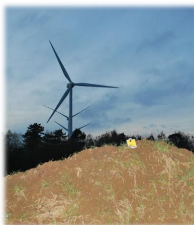
Photo 11 : AnabatSD1 installé au pied d'une éolienne
