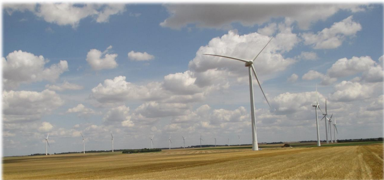
Photo 1 : Vue d'ensemble du parc de Vieux Moulin (au premier plan), avec au second plan le parc de la Vallée du Moulin, vue depuis le pied de l'éolienne 1 de Vieux Moulin (M. Acqueberge - Ecosphère)
