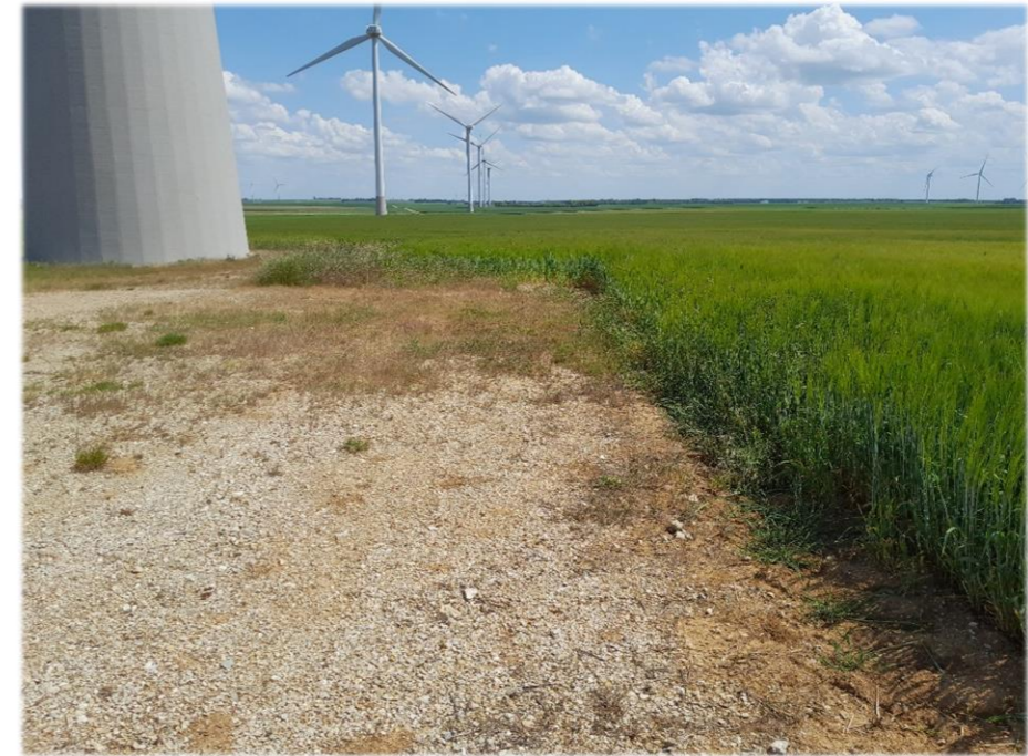
Aperçu des différentes classes de visibilité à proximité de l'éolienne SVO1 : plateforme (3 – bonne), herbe autour de la plateforme (2 – moyenne) et culture haute et dense (1 – nulle) (I. André, Ecosphère)
