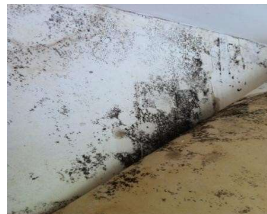
Contamination sous le papier fibre de verre
