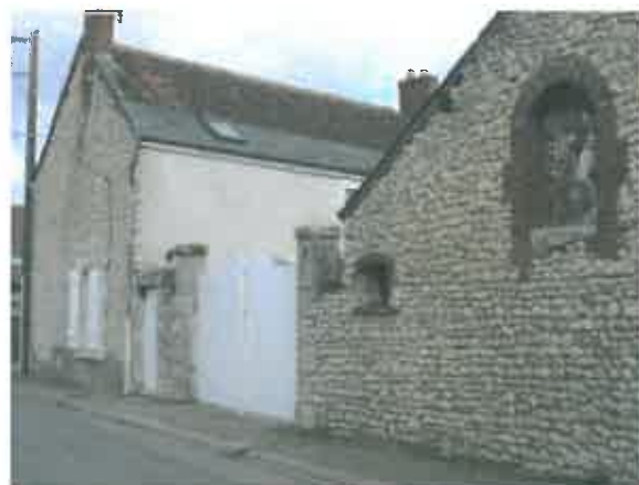
Pignons sur rue, cour fermée
