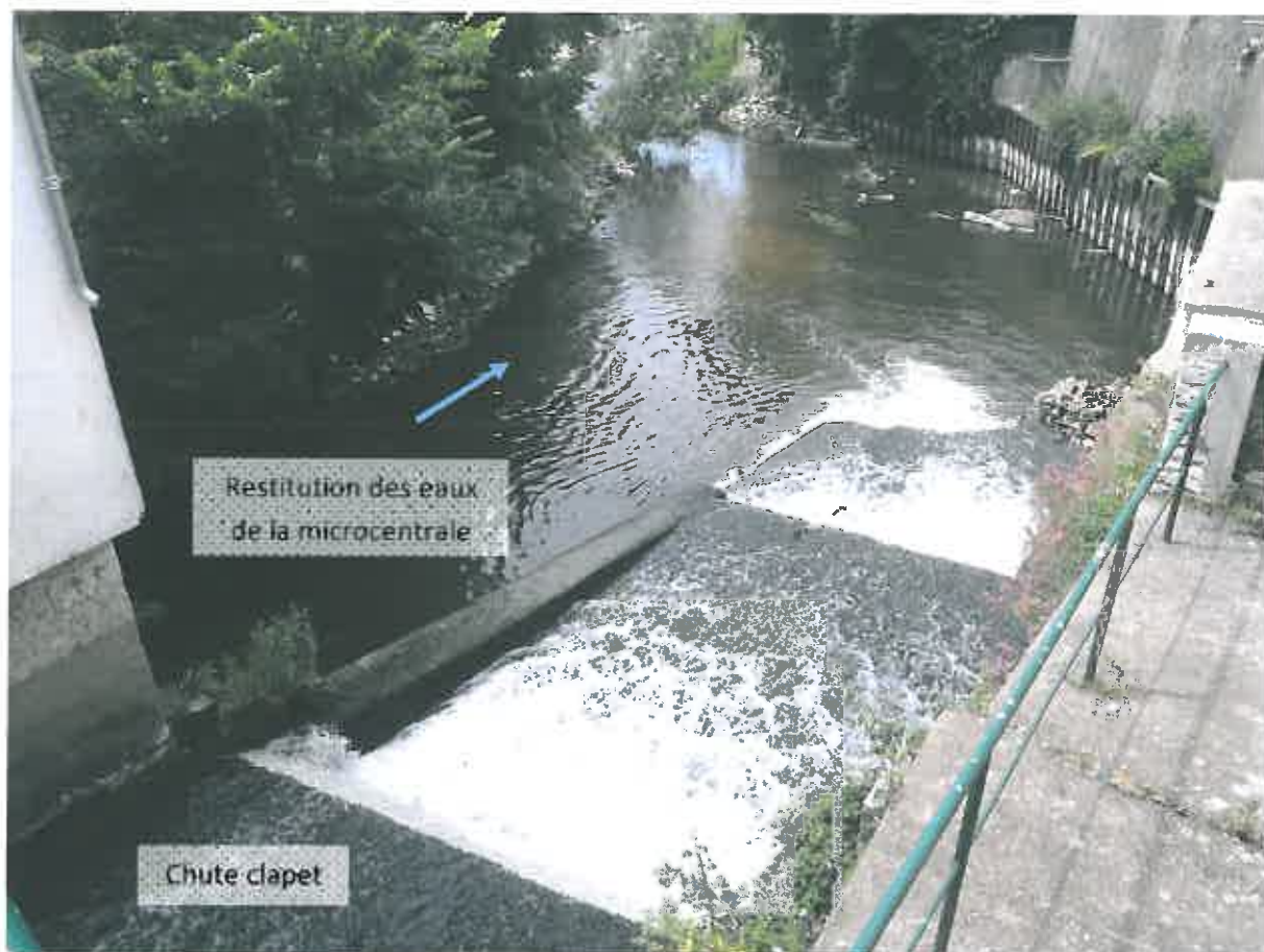
Prise de vue 2 : Vue de l'aval de la microcentrale (photographie du 2 juillet 2013)
