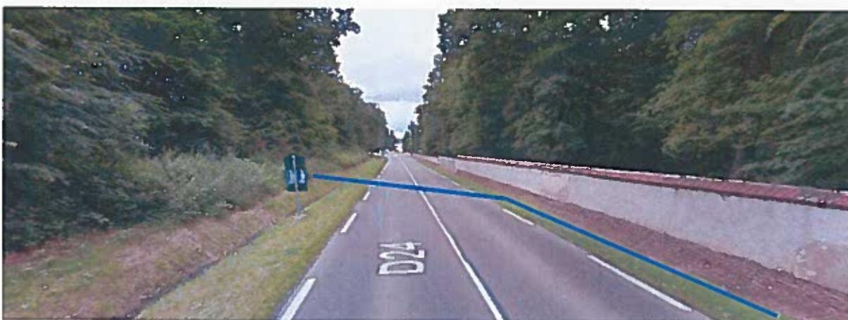
**Photo 29 : Longement de la RD24 sur l'accotement et fonçage sous la RD24 pour rejoindre le stade**
