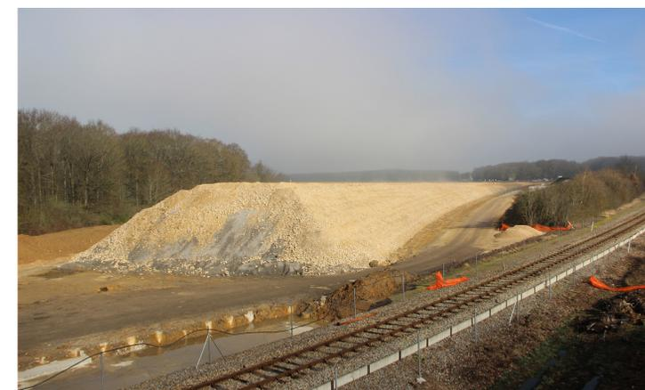
Mise en oeuvre par couches successives, jusqu'à 6 à 7 mètres de hauteur.
