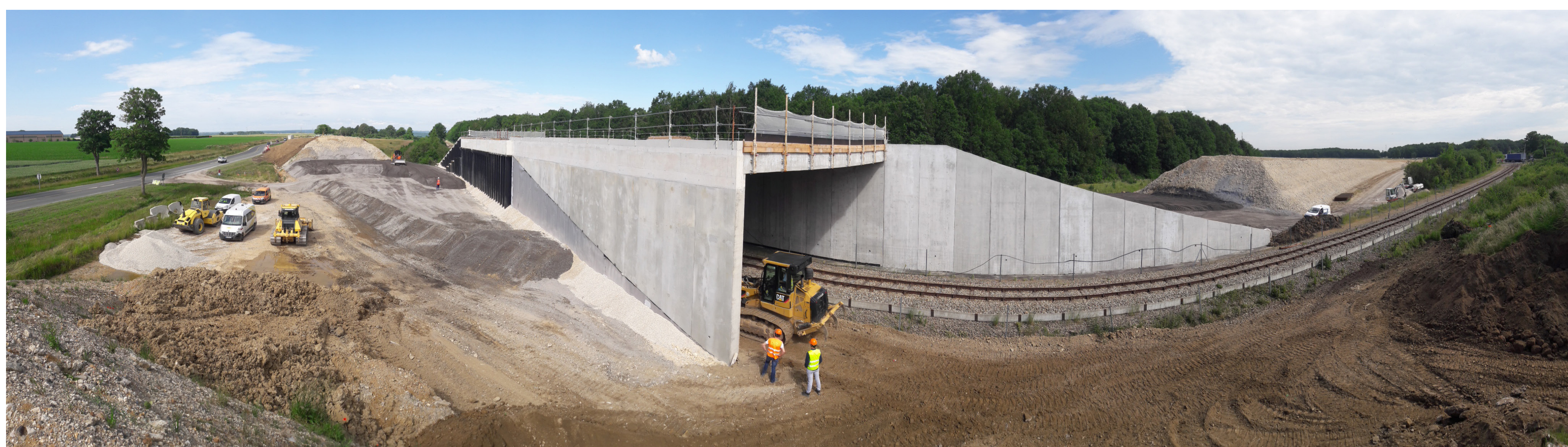
La dalle de transition, permettant la liaison entre l'ouvrage et les remblais, est réalisée.
