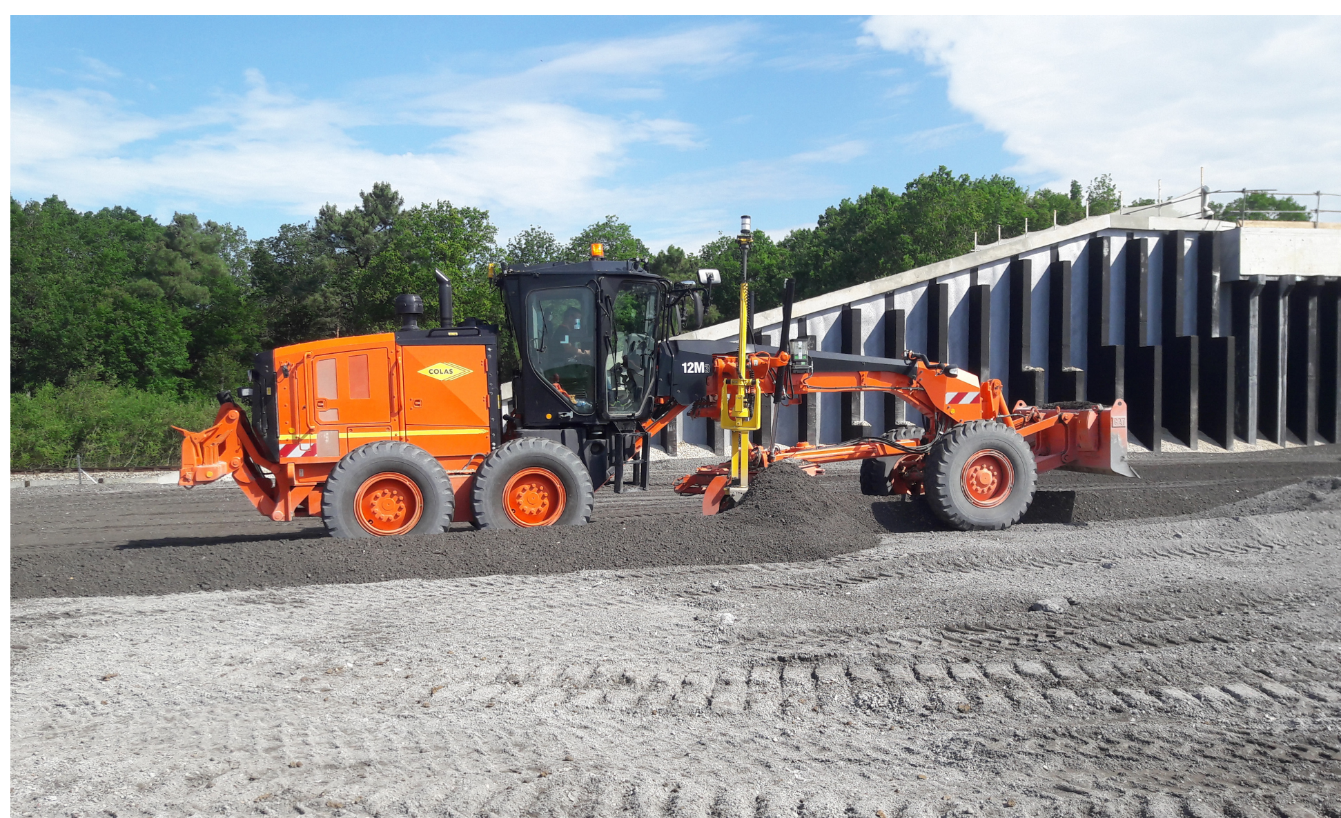
Les remblais proches de l'ouvrage, reposant sur les inclusions rigides, sont installés.
