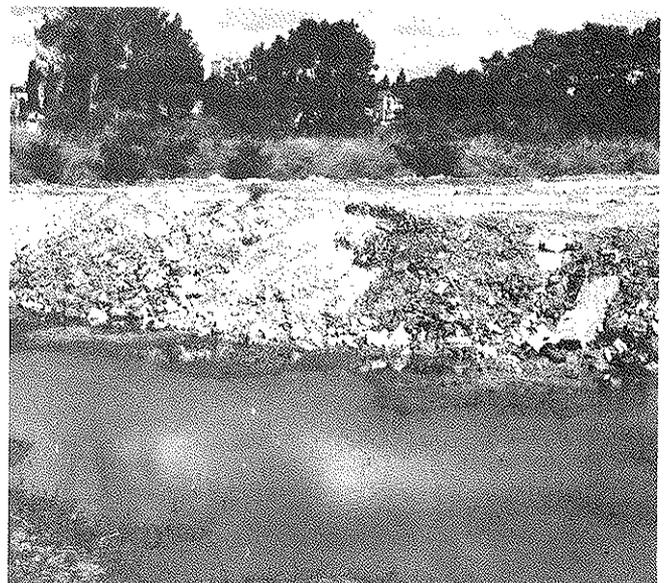
*Remblayage en cours avec des déchets inertes*
