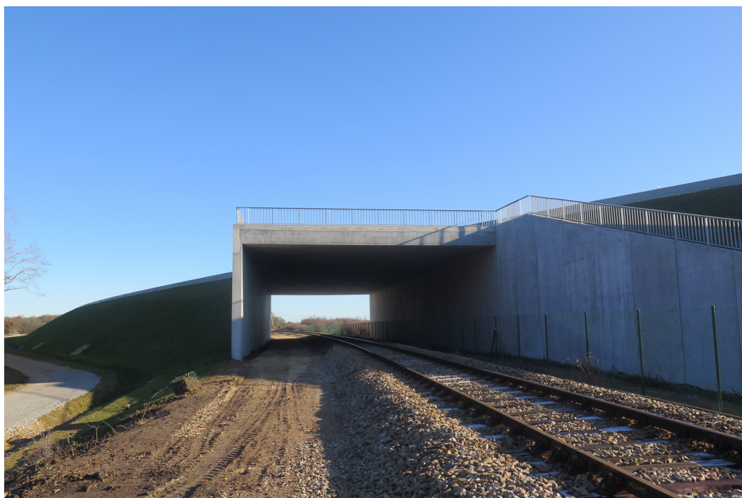
Vue du pont routier en portique ouvert
