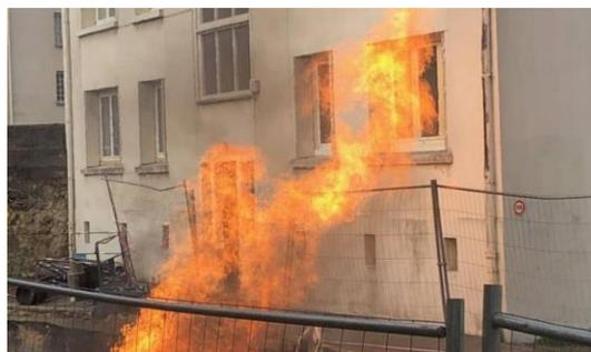
**Fuite enflammée d'une canalisation de distribution de gaz, endommagée lors de travaux.**
