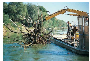
Photo de couverture Exemple de travaux d'entretien du lit: enlèvement d'encombre en Maine-et-Loire lors des Journées techniques du Club des gestionnaires du lit de la Loire (1999) Cl. Ph Auclerc - Loire & terroirs
