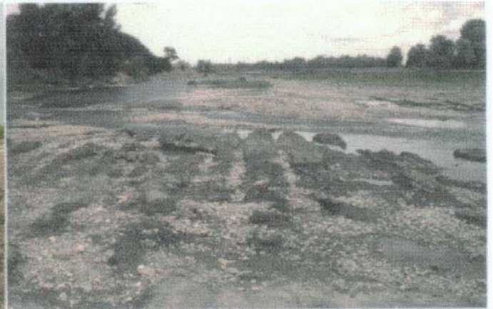
Remobilisation des sédiments après scarification et passage d'une première crue
