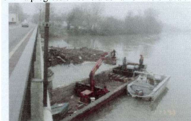
Dégagement d'encombres au niveau d'un pont à l'aide d'une barge
