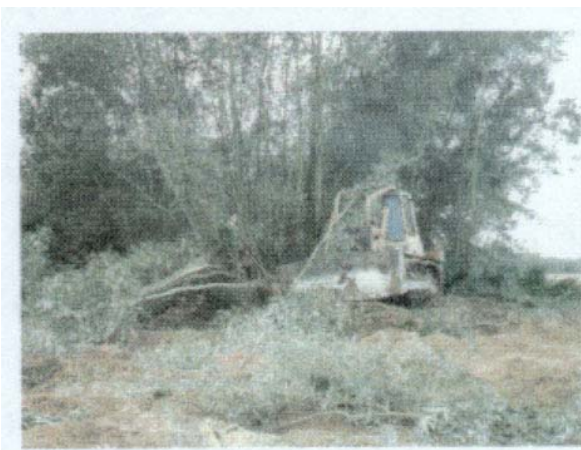
Dévégetalisation au bouteur d'un atterrissement sableux colonisé par une saulaie peupleraie
