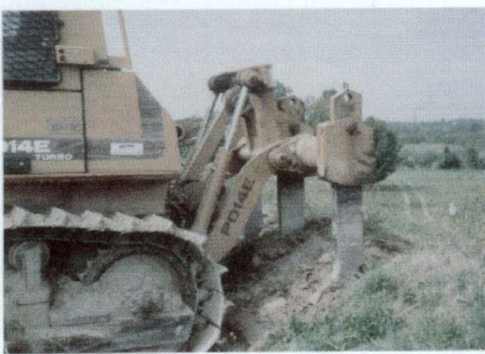
Bulldozer équipé d'un "ripper" destiné à scarifier les sédiments.
