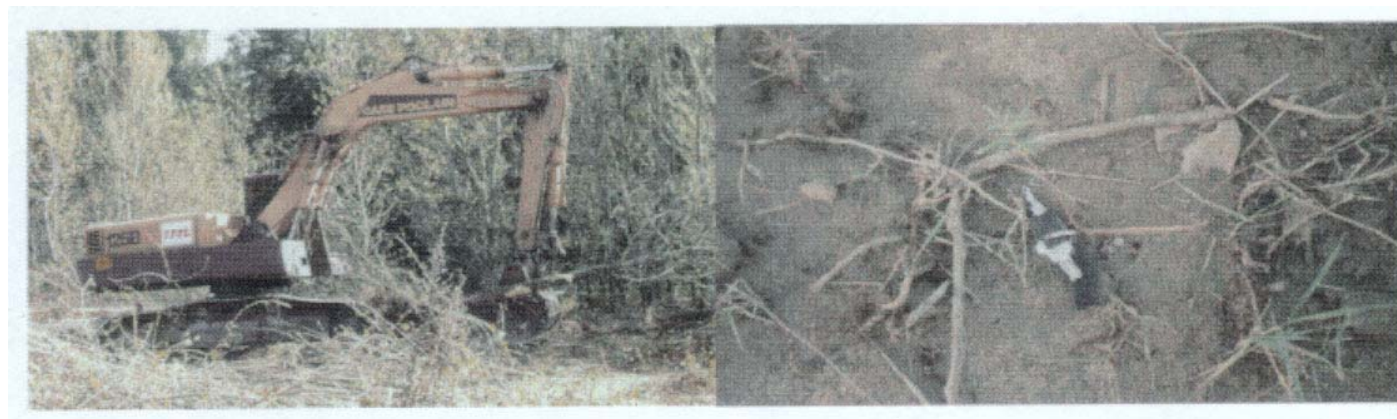
Utilisation de la pelle mécanique pour permettre un meilleur arrachage du système racinaire
