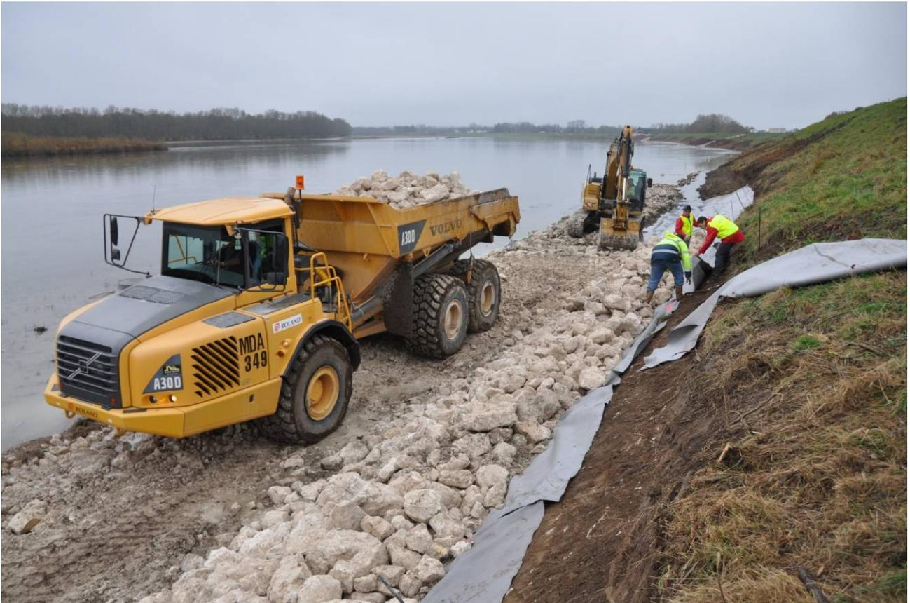
*Réalisation du renforcement du perré maçonné*
