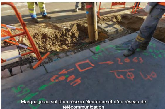
Marquage au sol d'un réseau électrique et d'un réseau de télécommunication
