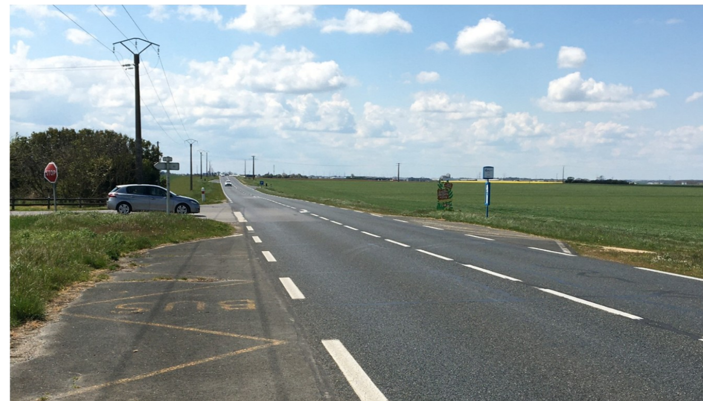
Le carrefour avec la route d'Issoudun et les arrêts du réseau de transport autocar
